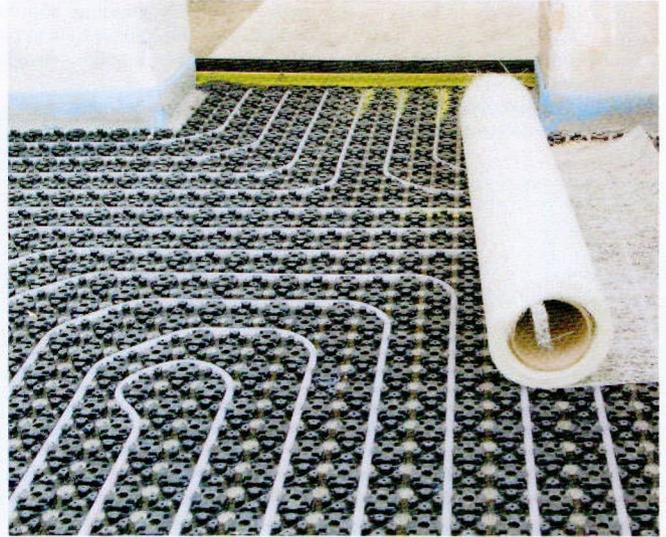
Das Armierungsvlies trägt zur hohen Lastaufnahme des Bodensystems bei. Es wird direkt auf die Dünnbettheizung aufgelegt.
